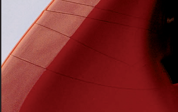
Rissbildung in der Oberfläche. Crack formation on the surface area.
